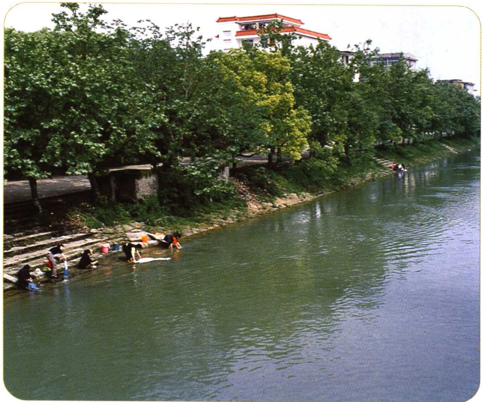
赣抚平原总干渠
