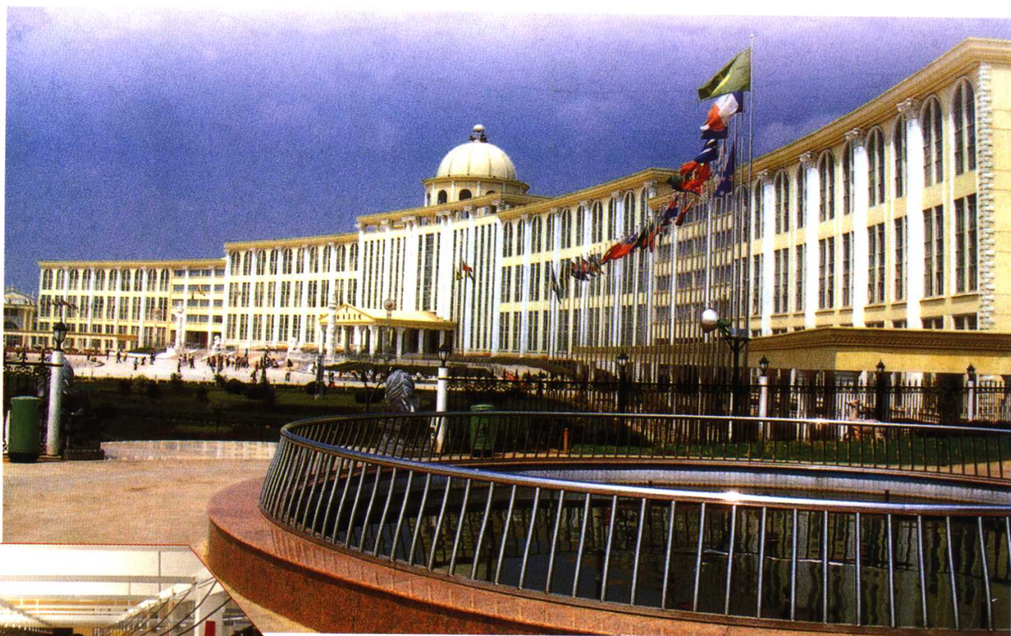
全欧式教学大楼
