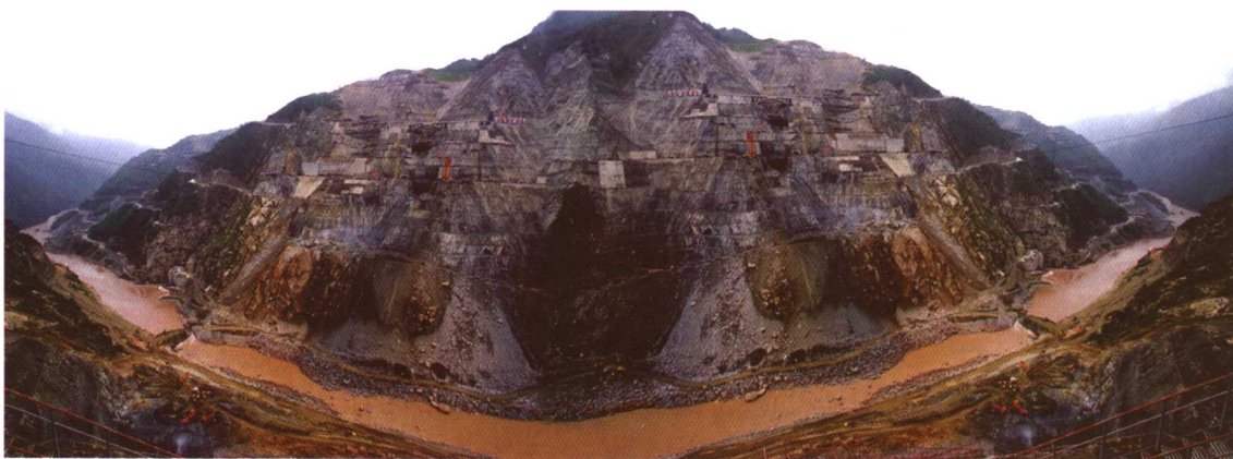
小湾电站建设现场
