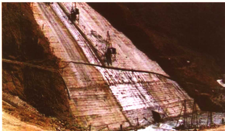
双江县南等水库建设现场
