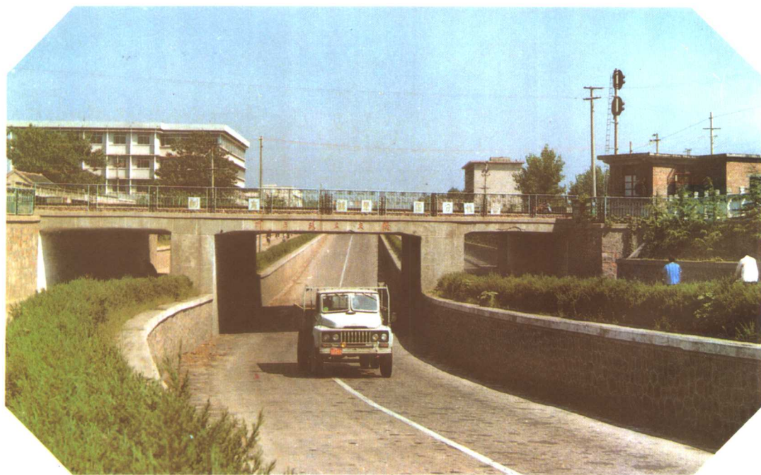
解放路立交桥
