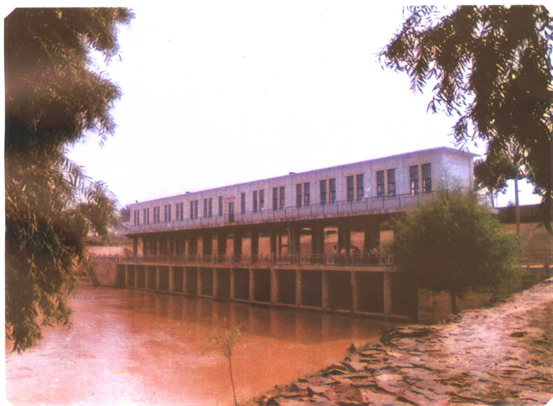
中牟赵口引黄灌溉渠首闸
