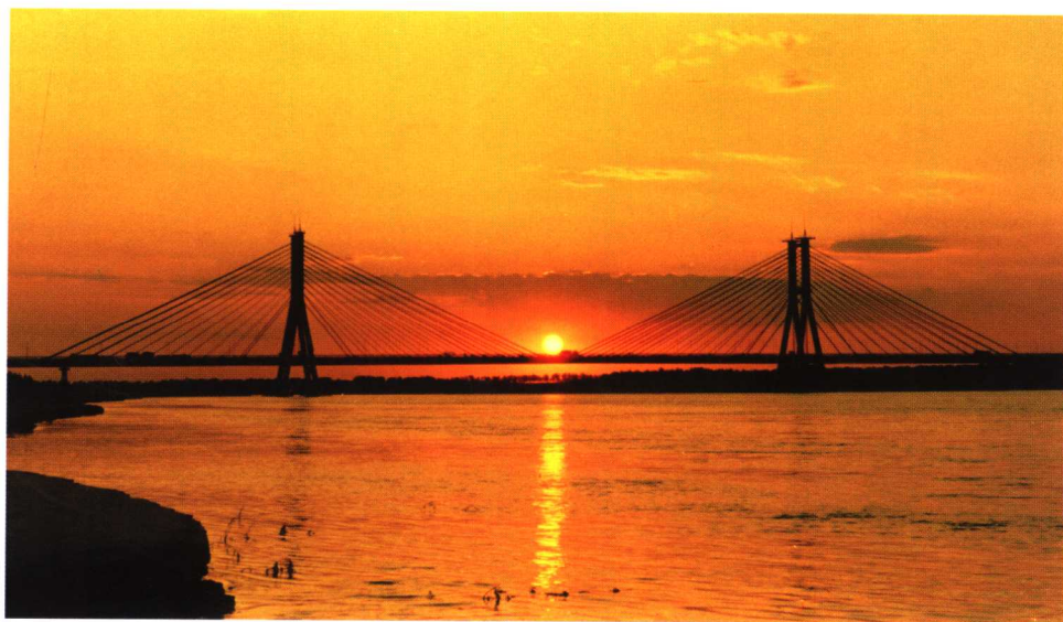
图 2 济南黄河大桥
