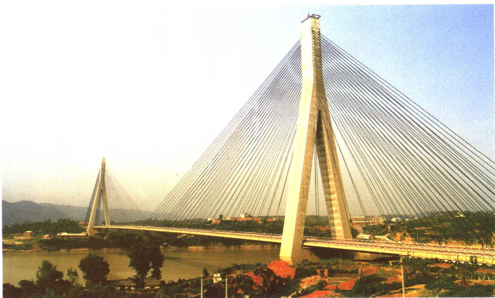
图 10 郧阳汉江大桥
