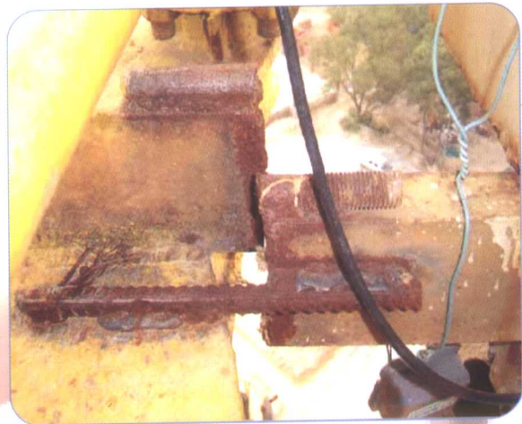
司机室固定梁断裂
