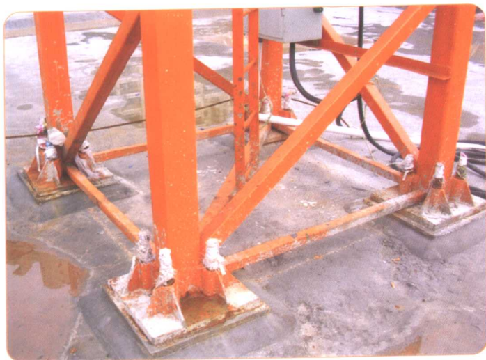
塔机基础螺栓应紧固有效
