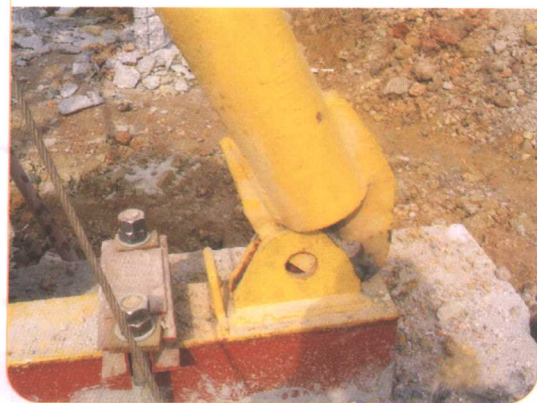
支腿与基础的连接方式应为销轴连接
