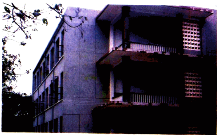
2 实验楼 1988年落成，建筑面积 1590平米，投资 23万元
