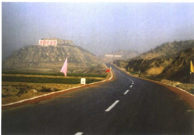
拓宽改造后的县乡公路
