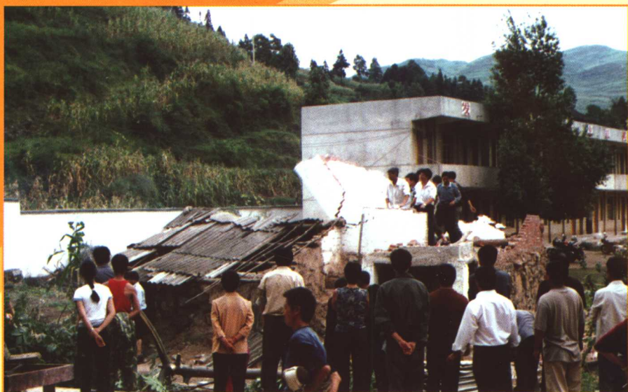
▲毕节市田坝乡拆除违法违章建筑。
