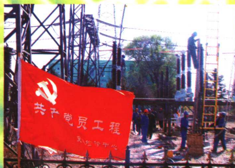
公司开展“共产党员工程”活动（图为施工现场）。
