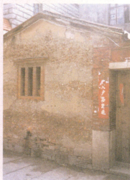
土墙(土、碎瓦片、灰拌合夯实而成)
