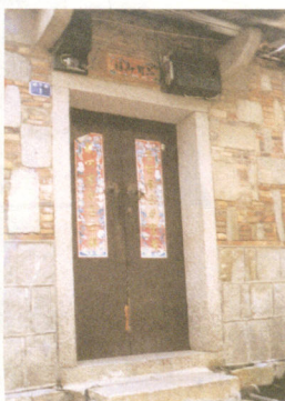
“出砖入石”墙(旧砖、石混砌)
