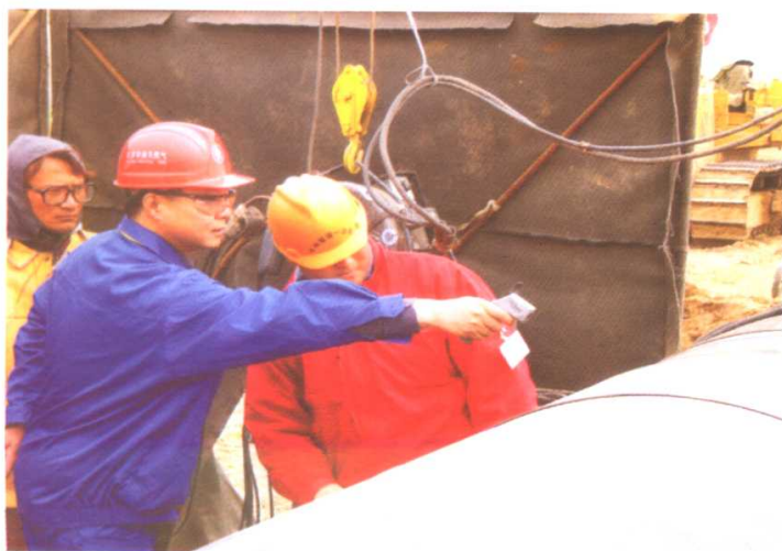
北京华油天然气有限责任公司副总经理、陕京二线项目经理部经理张余在现场检查
