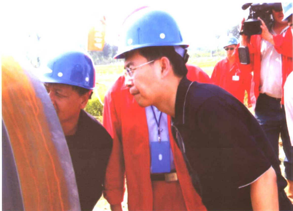
中油集团公司副总经理、股份公司高级副总裁苏树林在施工现场查看管道内涂层
