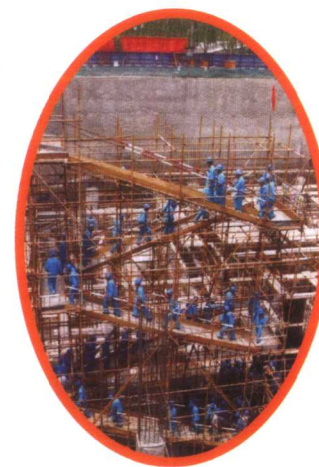
基坑上下通道
