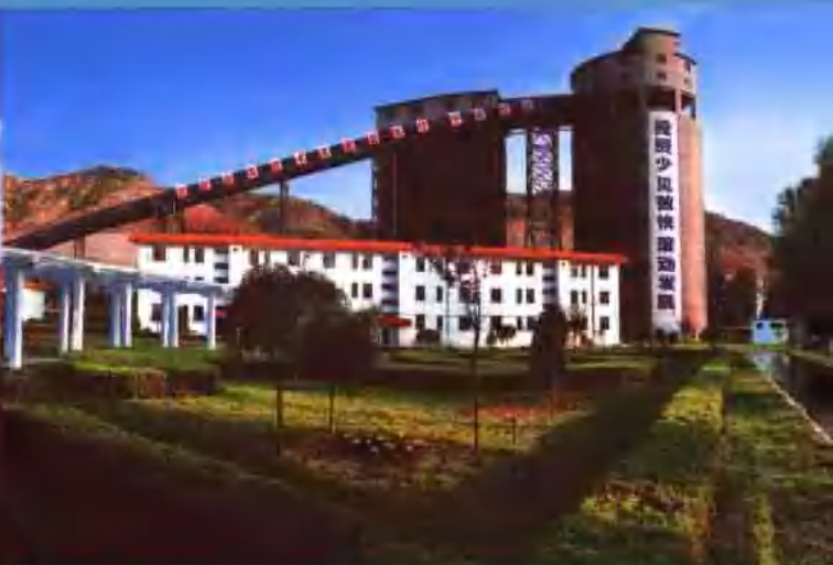
榆家梁煤矿仅用9个月18天就建成年产1000万吨的矿井，吨煤投资仅12元
