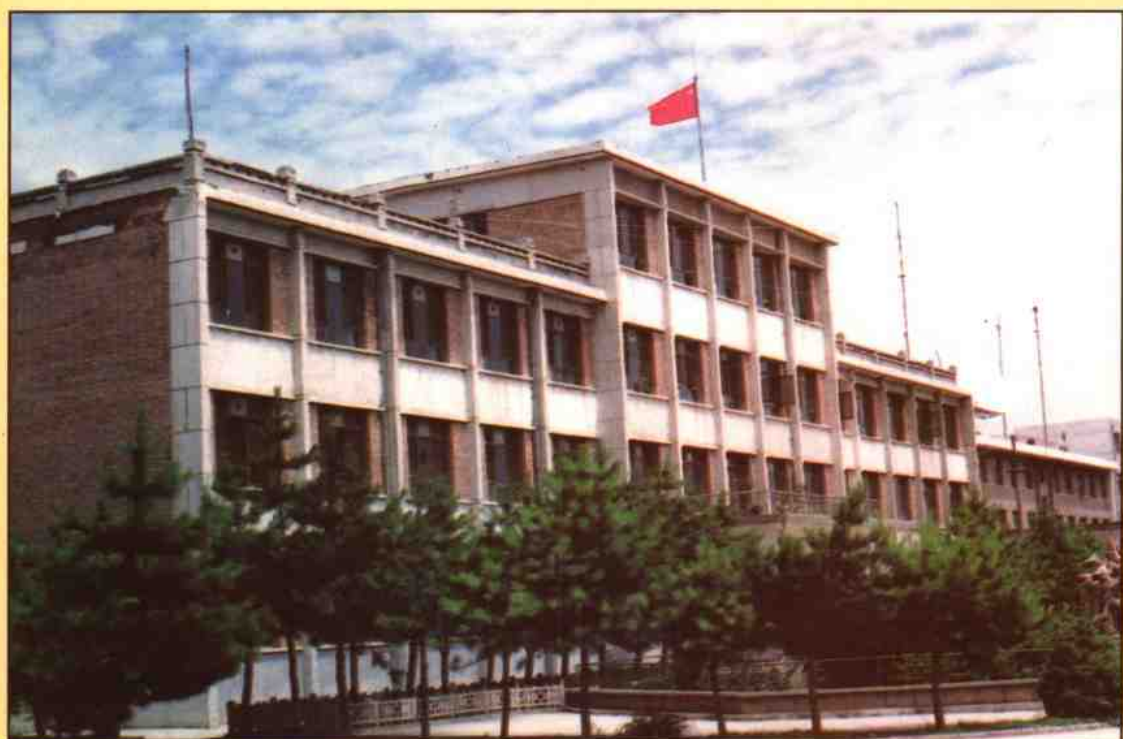
县人民政府办公楼
