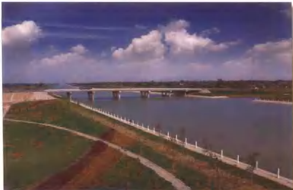
◎ 南水北调东线工程——三阳河
