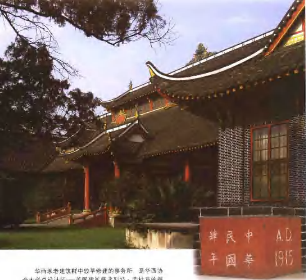
办公楼基石上用中西两种方式标记该建筑的建造年代。
