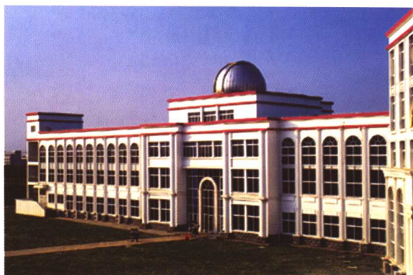
育才中学科技楼
