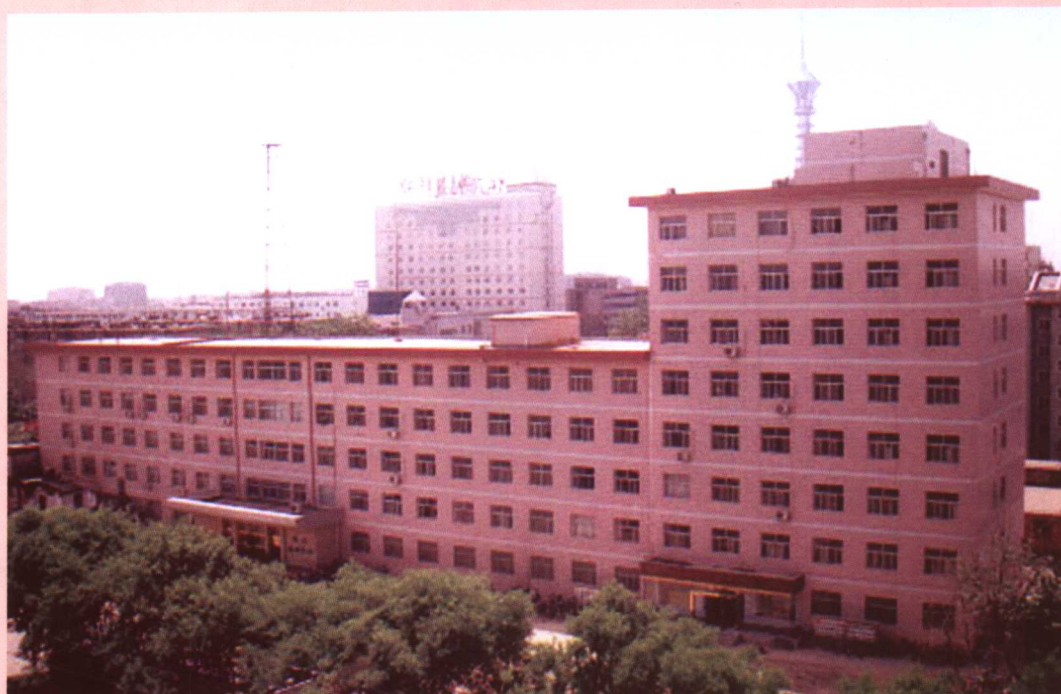
图1 河北省地震局办公大楼
