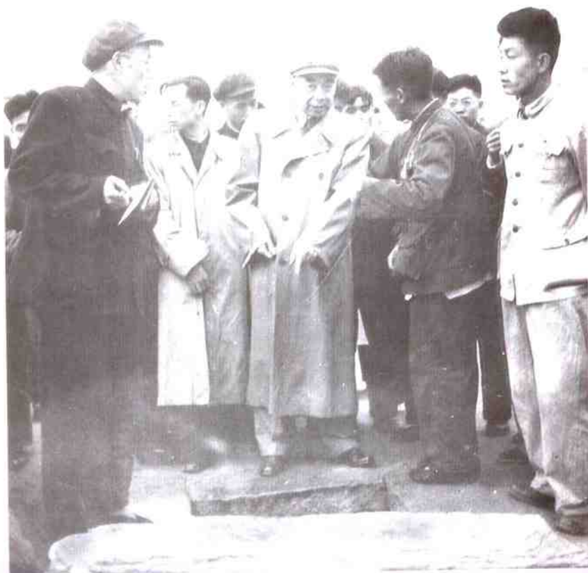
同日，周恩来总理视察偃师县东寺庄农业社的地下渠道
