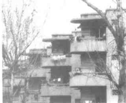
仪表厂锯齿式住宅楼
