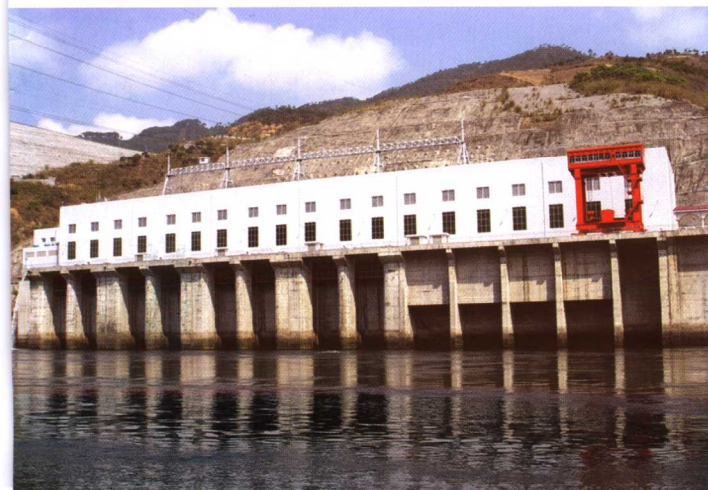
气势恢弘的发电厂房
