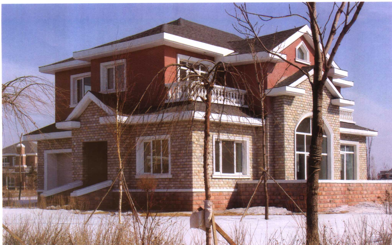
建筑单体特点是要表现建筑的庄重感，以体现业主身份和地位的尊贵。
