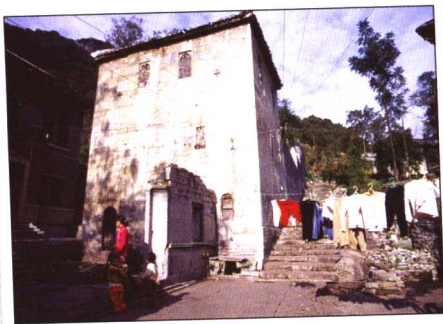
本寨民居 本寨的民居外围全用石块筑成，外墙一般不开窗户，而只有防御一望的枪口孔洞。内院多是木结构的老房子，木门窗上还能看到精细的木雕。
