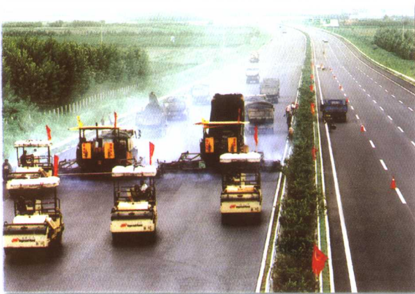
路面摊铺作业
