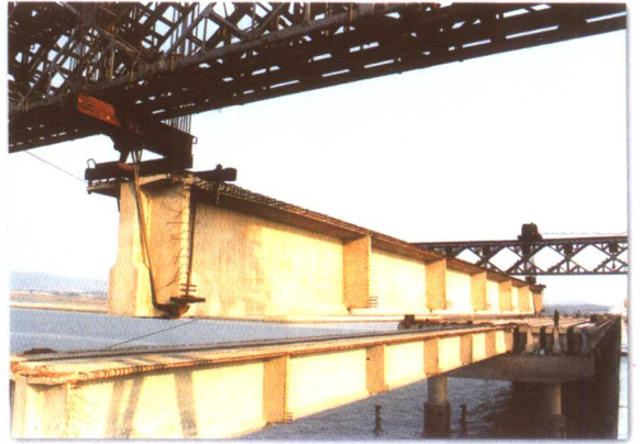
海湾特大桥预制梁吊装
