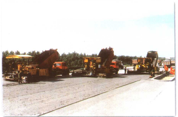
水泥稳定层施工
