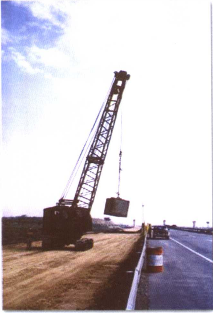
路基加宽强夯作业
