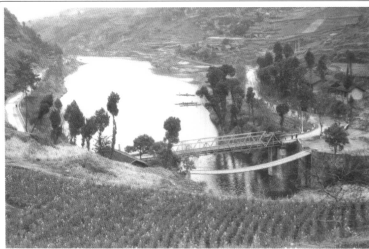
1873年修建的重安江铁索人行桥和1935年修建的钢梁公路桥
