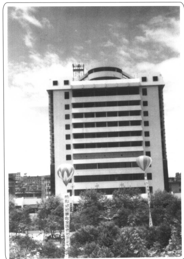
凯里民贸大楼
