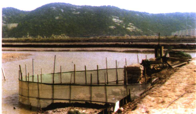
混养塘进水闸门 内的弧形保护网
