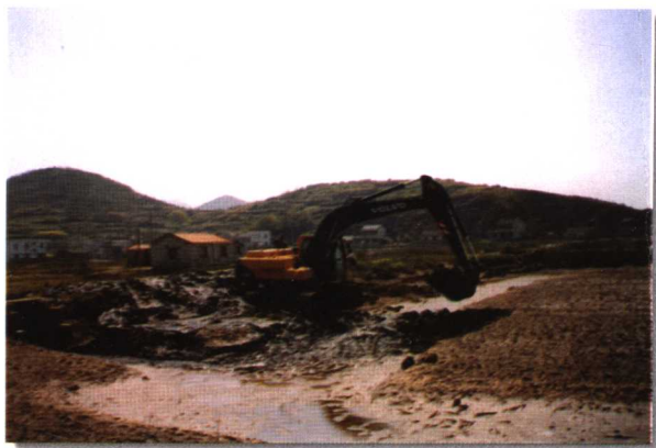
用挖土机整平池塘 并扩大环沟
