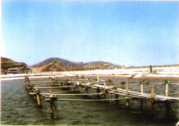
用毛竹搭建的 固定网箱架
