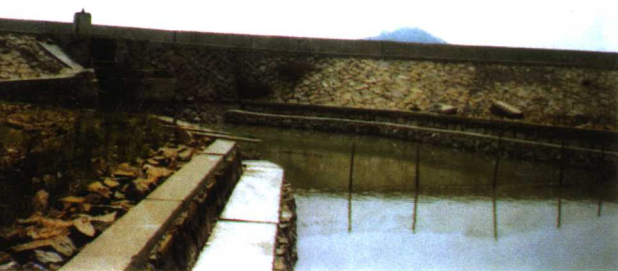
混养塘的水闸、闸网 及闸门前的保护网
