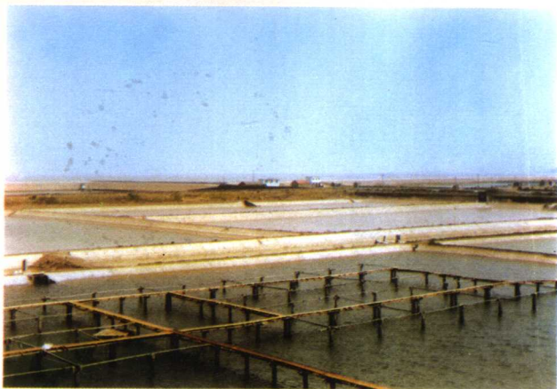
用水泥柱和木板搭 建的固定网箱架
