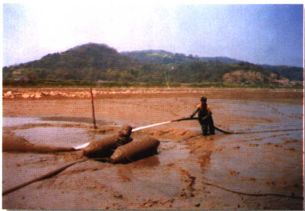
用泥浆泵清除淤泥
