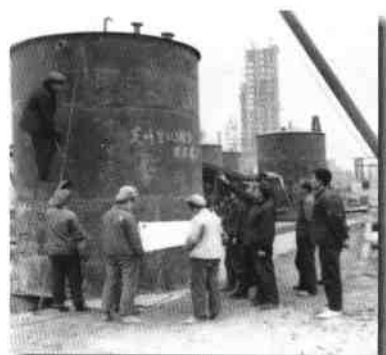
参加兰州、银川油库建设
