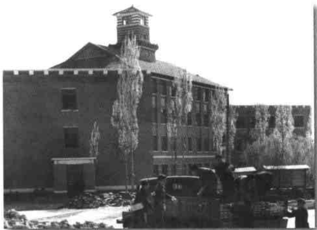
► 兰州化工学校学生宿舍楼
