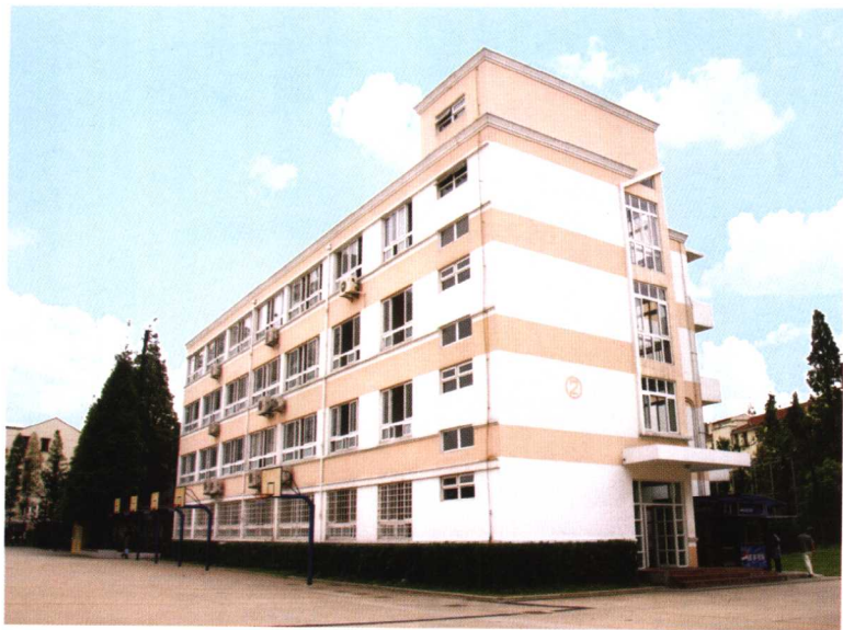
上海市北郊学校教学大楼
