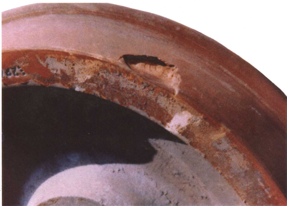
图 1-8 轮辋内部疲劳裂纹及裂损形貌之三
