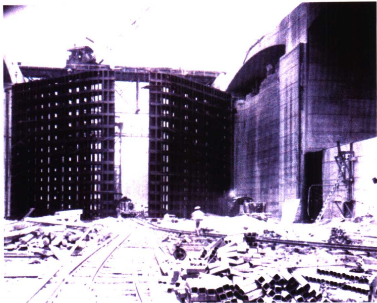
◀ 1913年正在建筑中的巴拿马运河下游闸门东段
