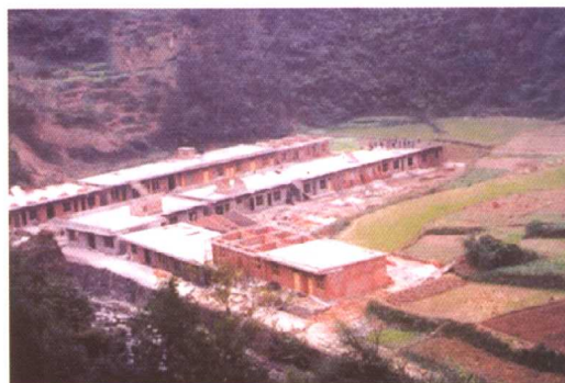
全县农村信用社支持高山移民工程 (图为建设中的移民新村)
