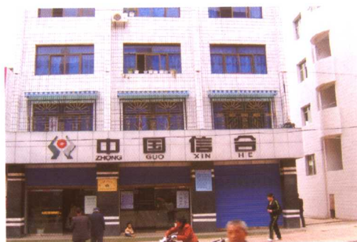
民胜农村信用社综合楼
