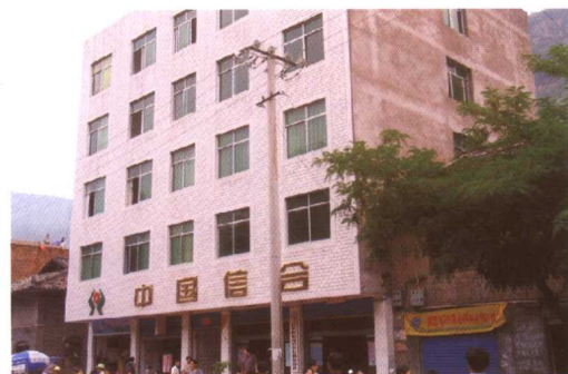
永安农村信用社泥溪分社综合楼
