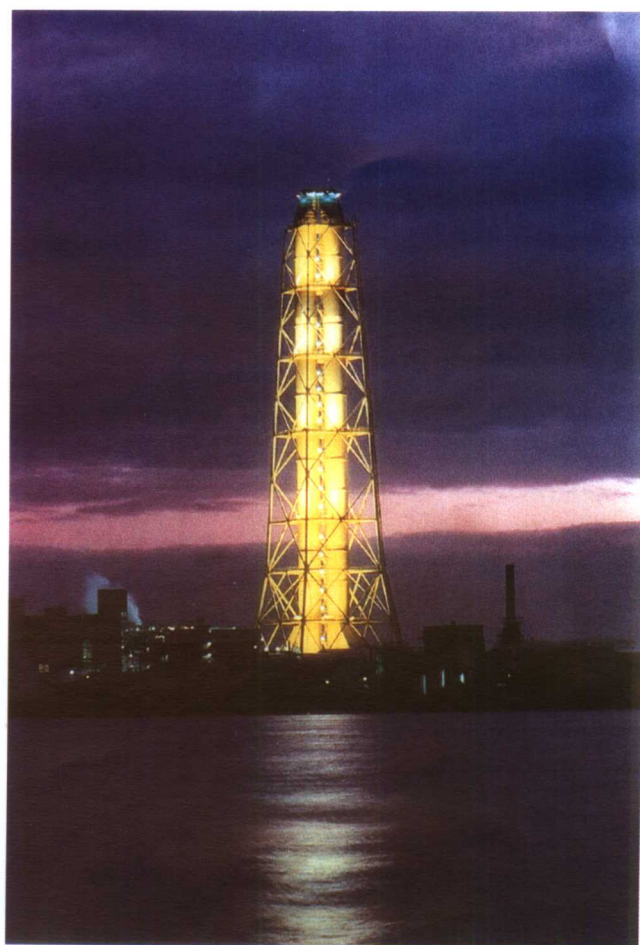
发电厂的烟囱，照明预报着季节、时间、潮汐和环境温度的变化
