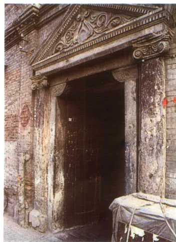
天津湖北路 1 号石库门, 已采用西式三角形山花、爱奥尼克柱式, 但仍保留中式石雕雀替, 中西并陈, 不拘一格
