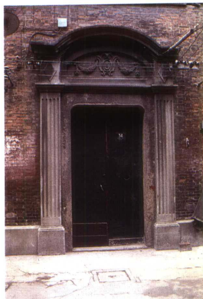
上海西湖路 34 号石库门, 简化的西洋古典柱式
