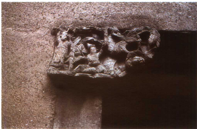
上海洪德里石库门硕果仅存的石雕雀替，其余部分已非原貌
