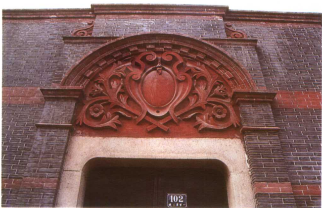
上海兴业路 102 号石库门，西化的装饰，砖工精细
