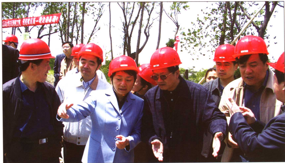
◆ 2004年4月26~29日，水利部副部长敬正书率国家防总淮河检查组检查淮河流域防汛抗旱工作。图为检查组查看洪泽湖大堤除险加固工地。（许江 摄）
