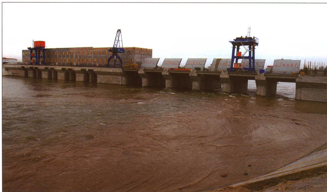
◆ 2004年3月27日，黄河沙坡头水利枢纽工程首台机组发电。
