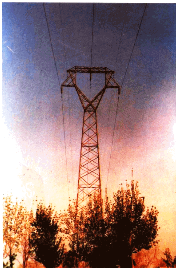
群英厂生产的高压线铁塔
