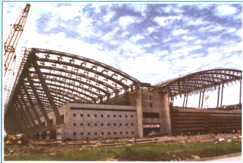
利用外国政府贷款项目——建设中的浦东国际机场候机楼
