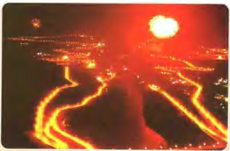
在建中的金沙江溪洛渡水电站夜景（夏延安 摄）
