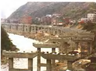
在建中的水（富）——林（柳河）高速公路（梁俊雄 摄）
