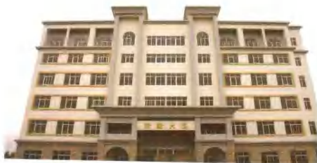
中心综合检验楼
