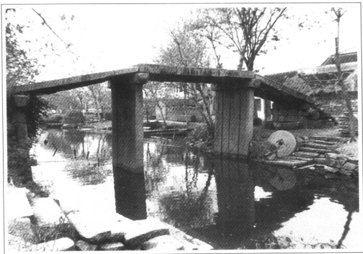
盛泽镇黄家溪泰安桥
