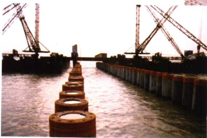
双排桩丁坝建设
