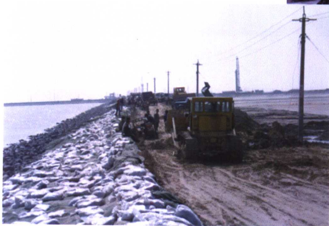
整修被浪潮毁坏的堤面
