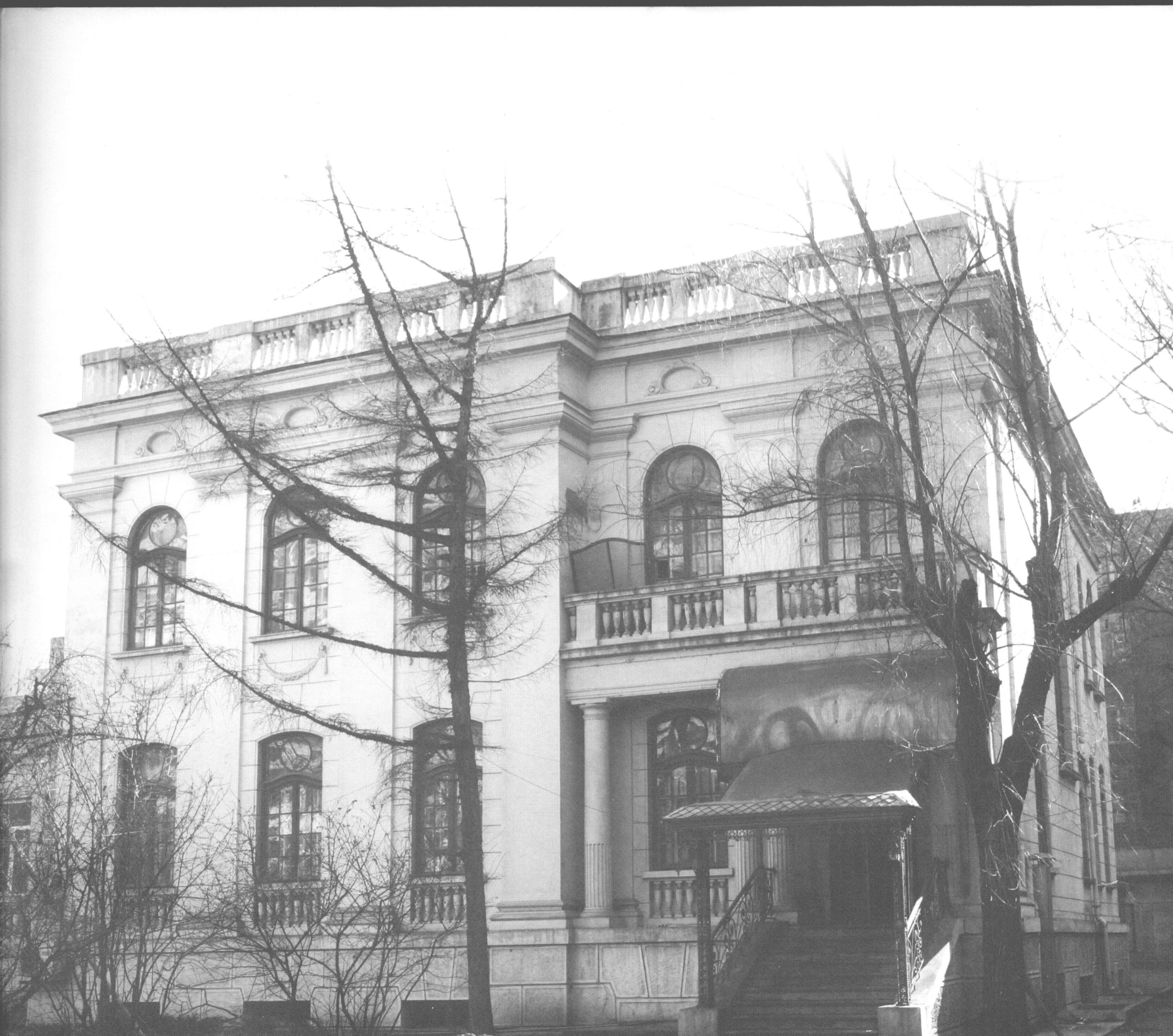
吉林街54号住宅楼
