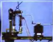
27.5 kV 单极隔离开关
