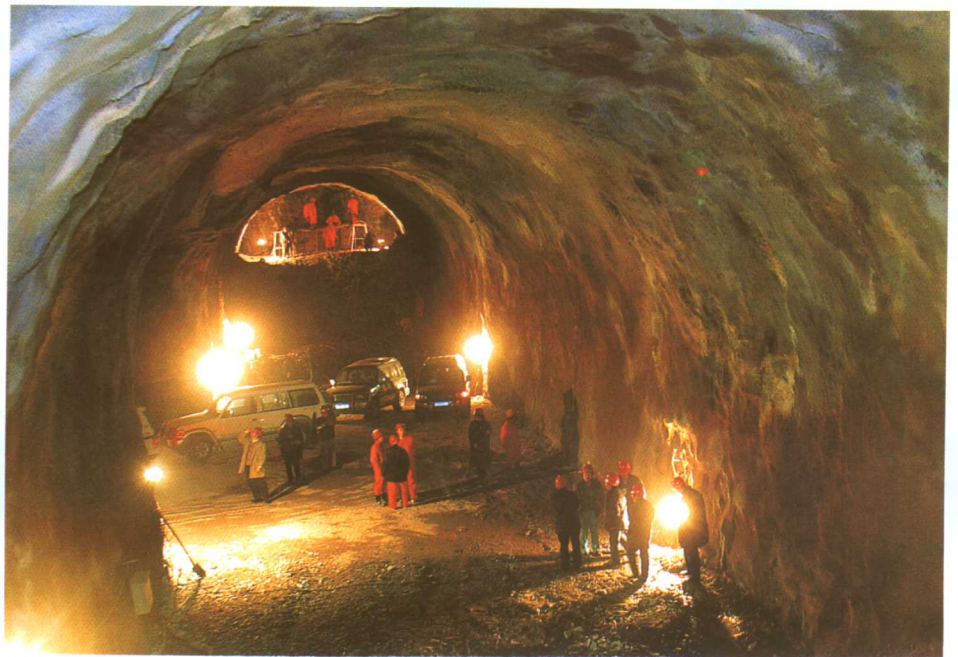
我国第一条客运专线——石太铁路客运专线太行山隧道正在紧张施工 田瑞夫 霍翼摄
