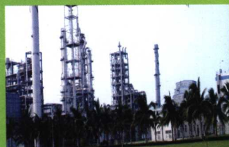
海南富岛化肥厂厂区一角
