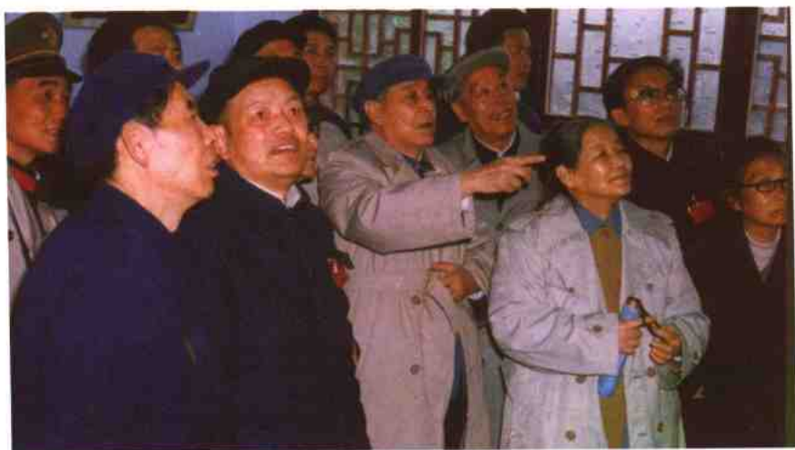
陪老领导秦天真、徐健生等在刚修复的中华苏维埃人民共和国川滇黔省革命委员会旧址内参观（1986年4月）
