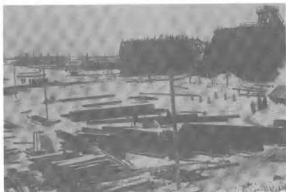
建设中的东清铁路机械总厂 Главный механический завод КВЖД в период строительства.
