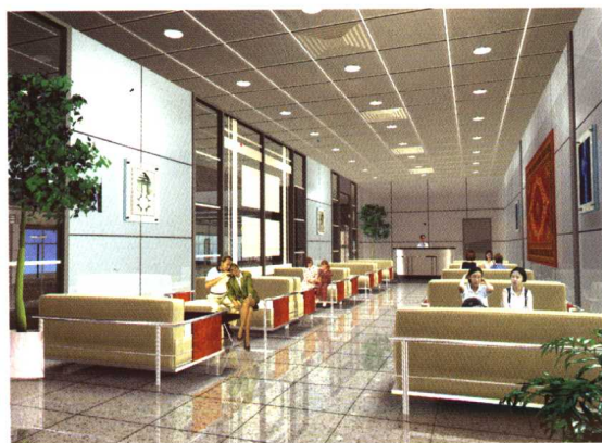
矿物棉吸声板吊顶
