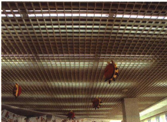
格栅型金属板组合吊顶
