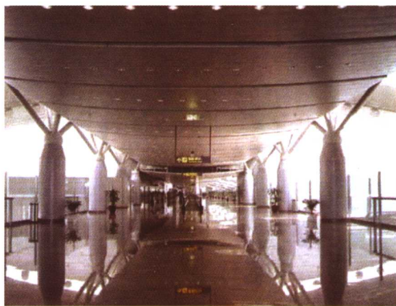
弧型金属板吊顶
