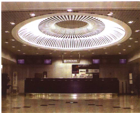
弧型金属板组合吊顶
