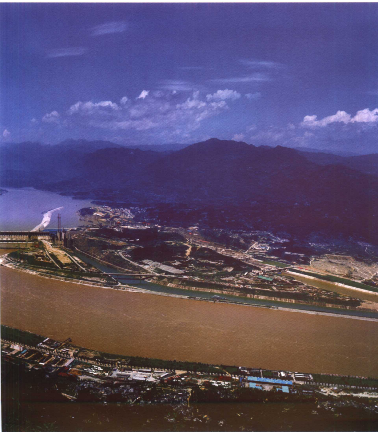
三峡水利枢纽
