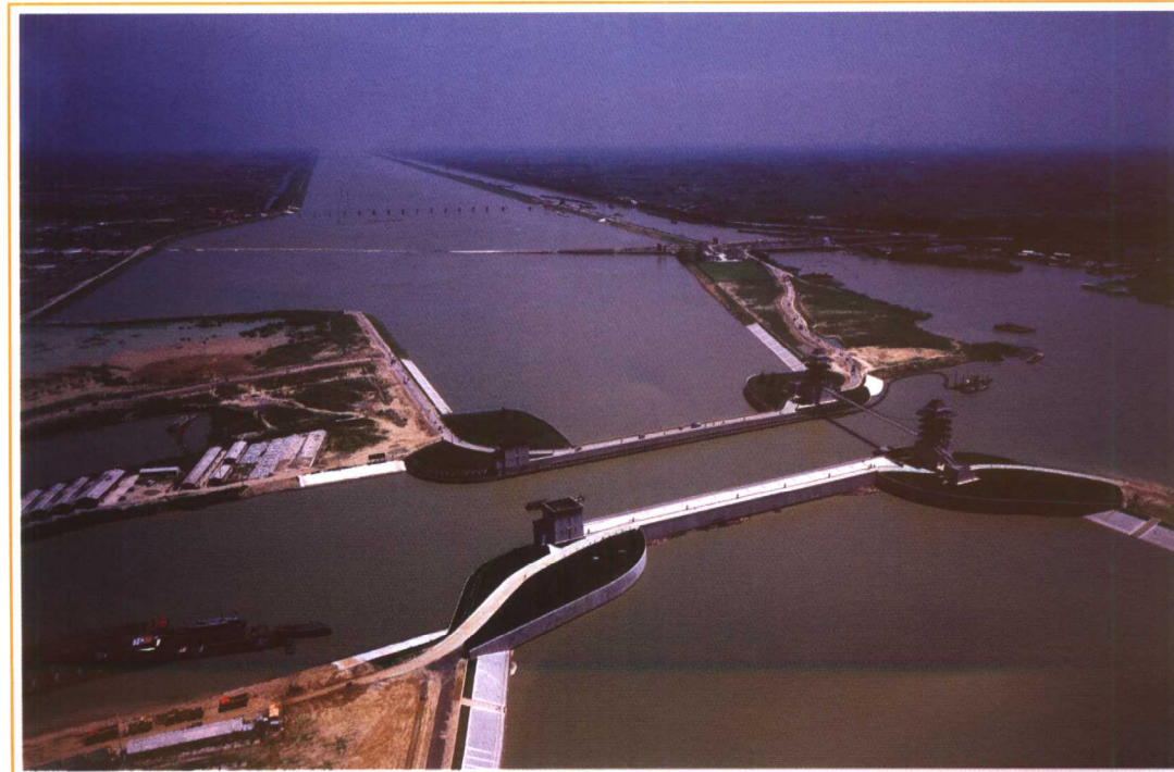
淮河入海水道淮安枢纽
