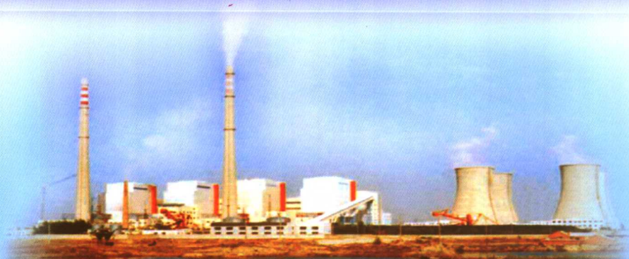
雄厚的实力为各类企业提供固定资产贷款、流动资金贷款、建筑业贷款等信贷业务。图为该行支持兴建的国家八五期间重点工程双辽发电厂。
