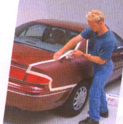
图 25-43 在要喷漆的部位周围围上一条细线,然后沿线粘上遮蔽纸。
