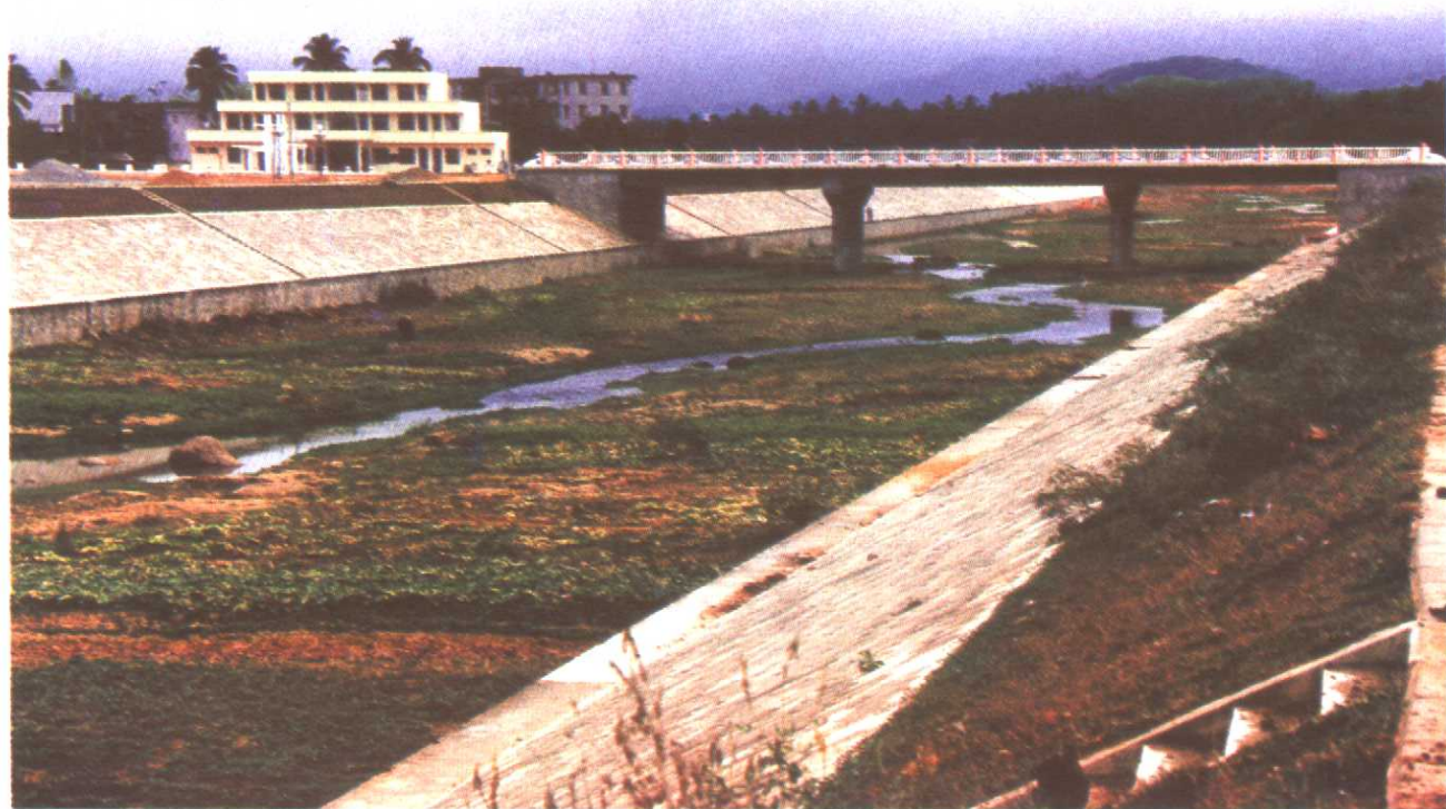
保亭县河道整治工程(摄于2003年)
