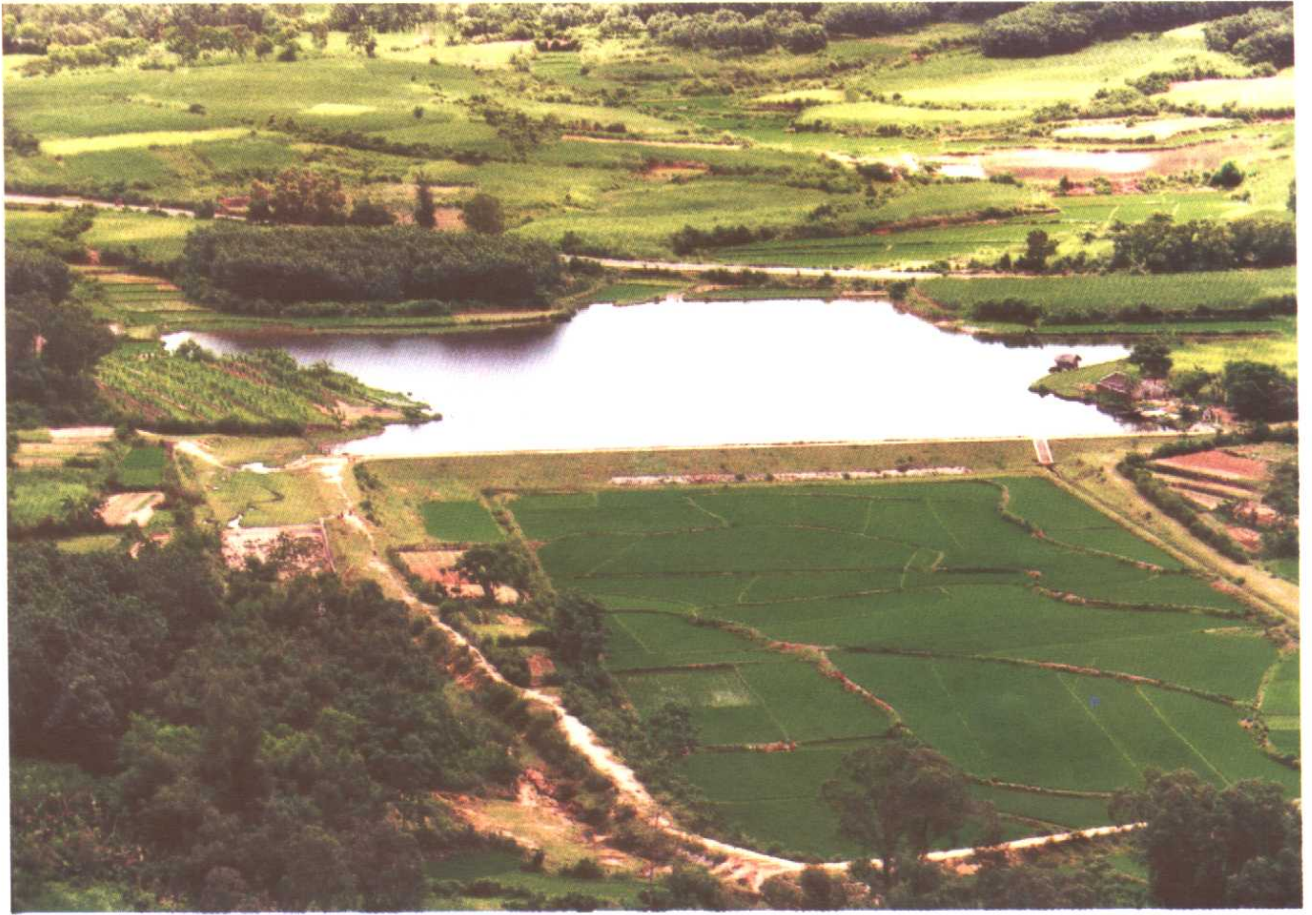
儋州市雅镇山塘水库工程(摄于 2000 年)
