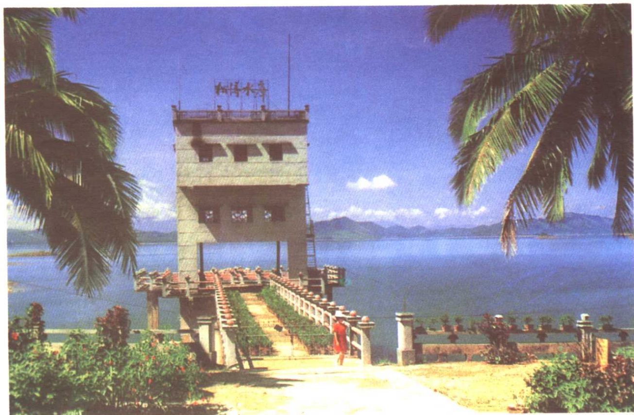
松涛水库南丰输水隧洞进水塔(摄于1993年)
