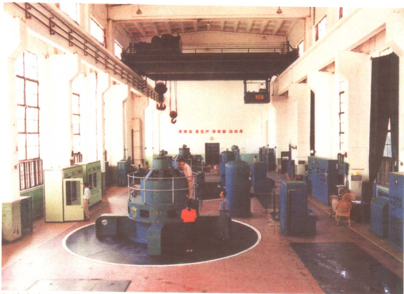
松涛水库南丰电站厂房(摄于1999年)
