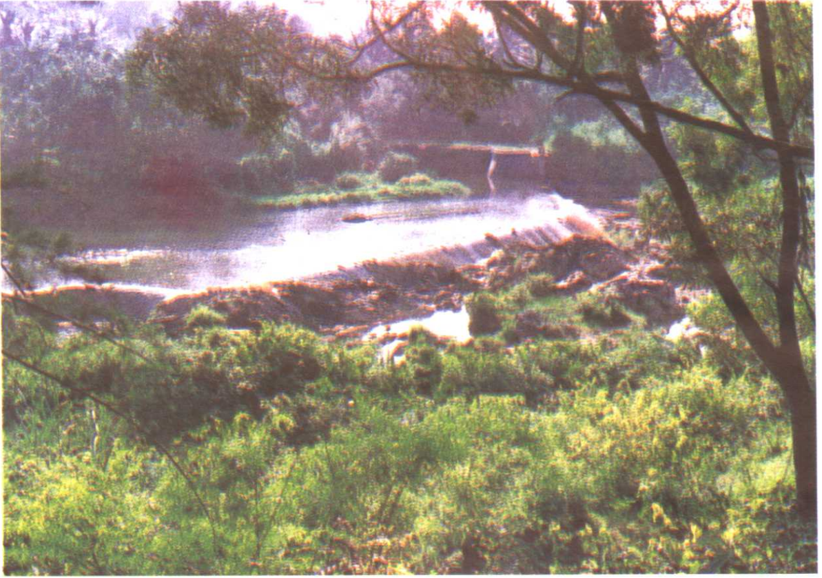
金聪水陂。清代兴建的草木坝，日军侵琼期间改为混凝土水坝，解放后，1951年修复，1955年扩建，灌溉面积1万亩。
