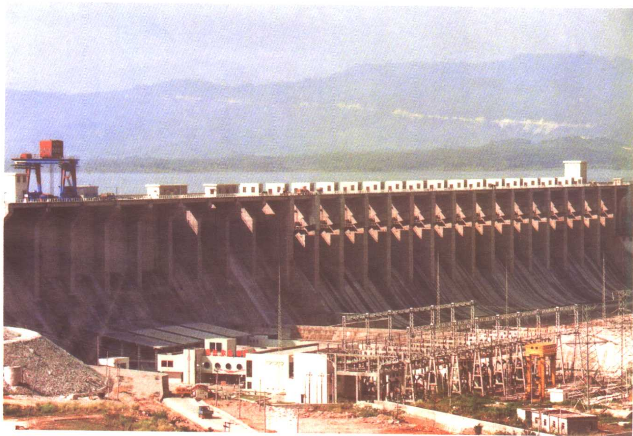
大广坝枢纽大坝(摄于1995年)
