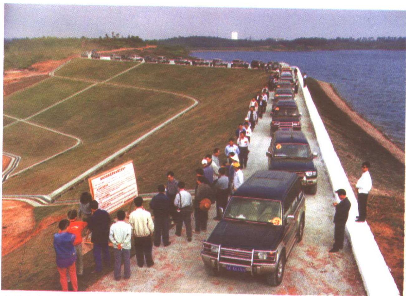
南扶水库大坝(摄于 2000 年)
