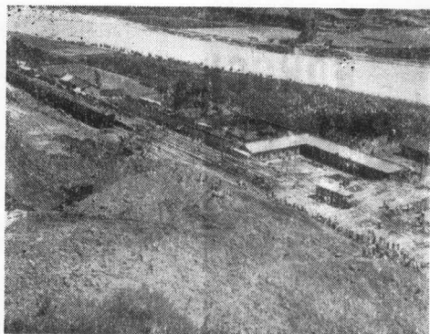
↓⑤89工点铁路上泥流堆积
