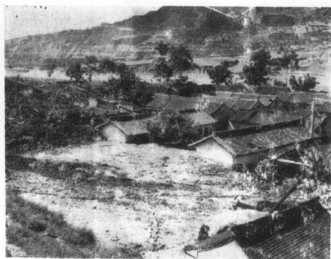
介③89工点泥流淹埋房屋情况
